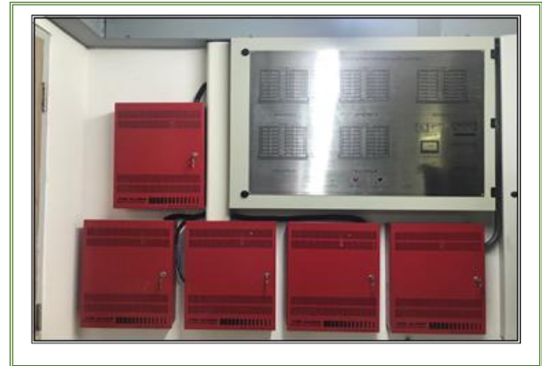
รูปภาพที่ 1.51 รูปภาพระบบ Fire Alarm ในห้อง Control
