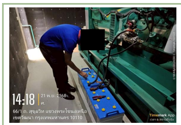
รูปภาพที่ 1.42 การตรวจสอบระบบจ่ายไฟสำรอง
