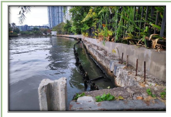
รูปภาพที่ 1.1 ภาพSheet Pile ความลึก 14 เมตร
