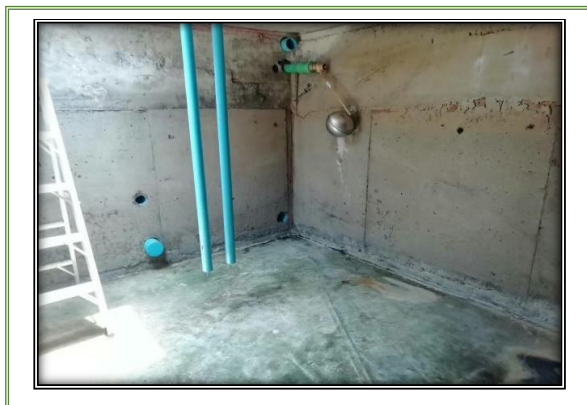
รูปภาพที่ 1.79 การตรวจสอบวาล์วควบคุมการจ่ายน้ำ
