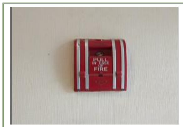
รูปภาพที่ 1.53 รูปภาพเครื่องแจ้งเหตุโดยใช่มือดึง (Fire Alarm Manual Station )
