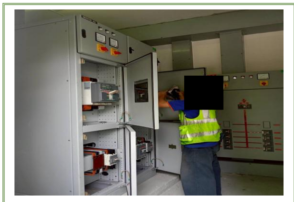
รูปภาพที่ 1.42 การตรวจสอบระบบจ่ายไฟสำรอง
